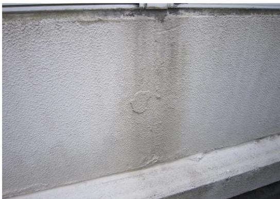
窓枠のシールが破れ雨水が滲入して、壁の内側から室内へ。
