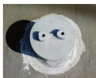
排水が終わり蓋を被せた状態
